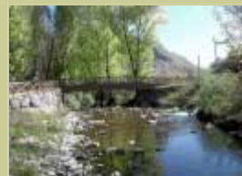
Pasarela sobre el Sil.
