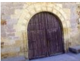
Palacio blasonado de Benllera
