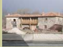
Casona en obras.
