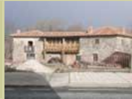
Casona en obras.
